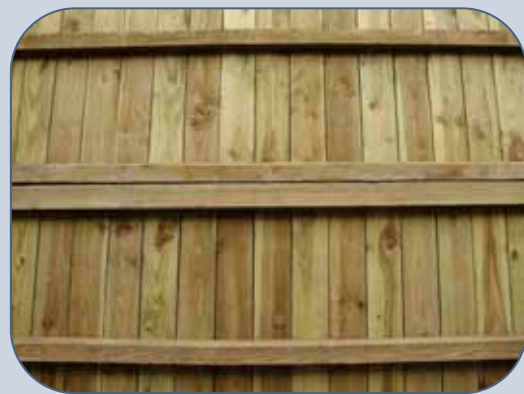
(d) Detail of rear of barrier panel
