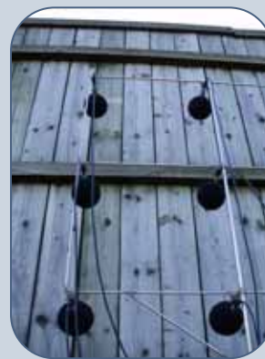
(d) Detail of rear of barrier panel
