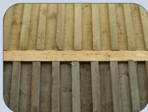
(d) Detail of rear of barrier panel
