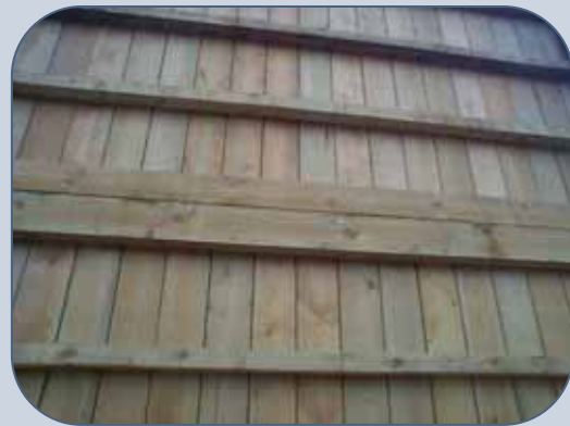
(d) Detail of rear of barrier panel
